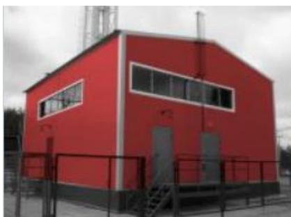
**Топливо:** газ природный, легкое или тяжелое жидкое топливо. Тип котлов: КВа-1,0 Г/Ж (БОГАТЫРЬ 3 Г/Ж с газовыми, жидкотопливными или комбинированными горелками).
